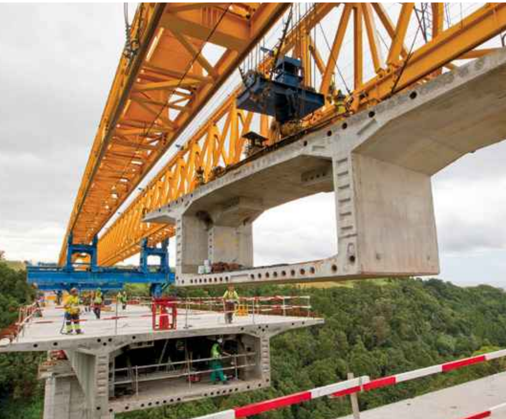
Obras de construcción de una autopista, realizada por Ferrovial en las Azores.
