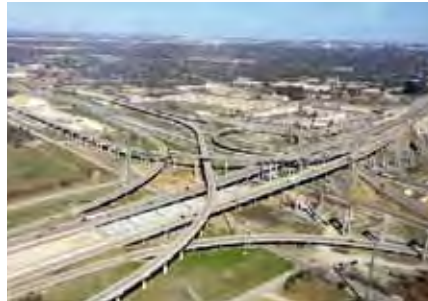
Las adjudicaciones en infraestructuras de Ferrovial tienen que ser comunicadas a los diferentes grupos de interés. En la imagen, el viaducto de Mondáriz, en Cantabria y la autopista LBJ Express en Dallas, EEUU.
